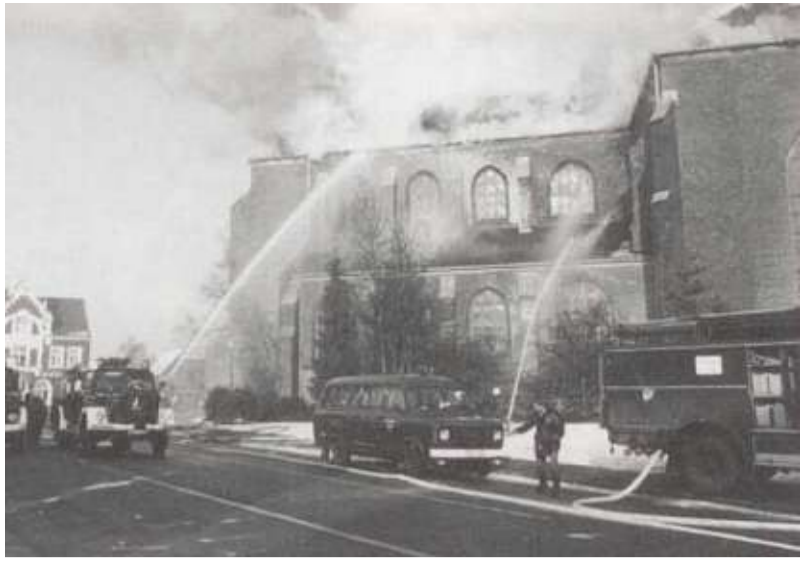
Die Feuerwehr löschte von außen, es war zu gefährlich, in die Kirche zu gehen. Es bestand Einsturzgefahr.
